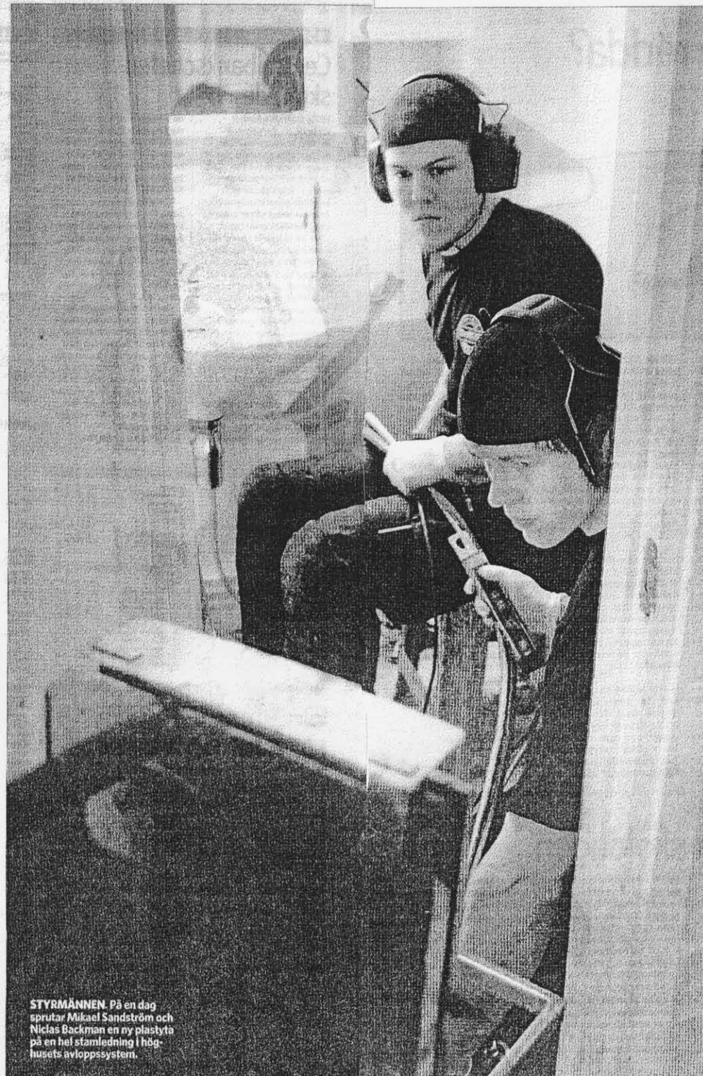
NY YTA. Efter rengöring och kontroll av rören börjar ytbläggningsarbetet, från nedersta våningen uppåt.
